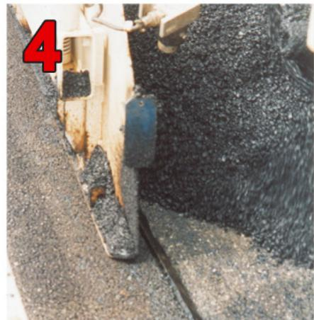
Seejärel paigaldage kuum asfalt, mille temperatuur peab vuugilindi sulatamiseks vuugi piirkonnas olema vähemalt 120 °C (joonis 4).
