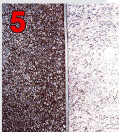
BORNIT®-Fugenband on täielikult ümbrisetud (joonis 5). Vuugilint sulab kuumas asfaldis ja tungib valtsimisel sügavale ühenduse terastruktuuri. Nii tekib elastne ja veetihe ühendus, mis ei lase pikka aega pragudel tekkida (joonis 6)
