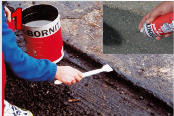
Katke lõigatud asfaldi- või betooniserv kõigepealt krundiga BORNIT®-Bitugrund või BORNIT®- Haftkleber.
