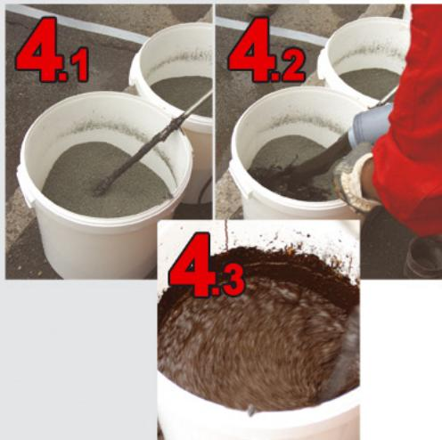
Kõigepealt segage seguri abil killustik ja kövastumist kiirendav pulber (joonis 4.1). Seejärel lisage vett, kuni massil on niiske betooni konsistsents. Lõpuks lisage bituumenemulsioon ja segage seni, kuni tekib ühtlane segu (joonis 1.3). Kõrgema temperatuuri korral võite lisada segule veidi rohkem vett.
